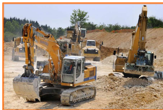
Travaux de terrassement sur le chantier.
