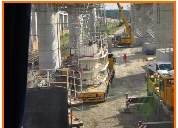
La construction de l'estacade
