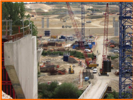
Un chantier grouillant et ordonné
