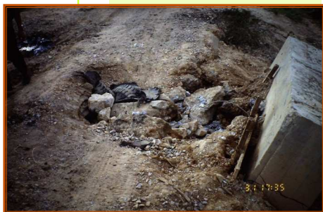
La charge avait été judicieusement placée en un point de passage obligé.
