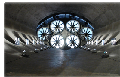
Intérieur du diffuseur de la Grande Soufflerie de Chalais-Meudon (Hauts-de-Seine)
